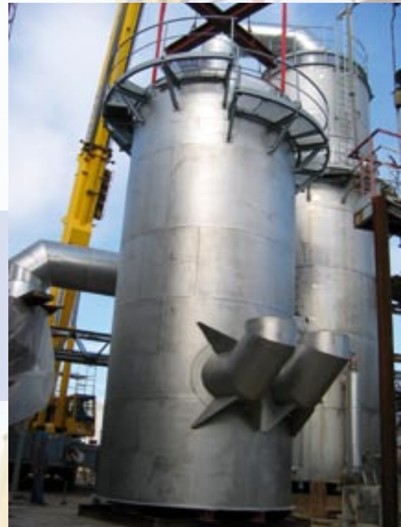
Priprave za postavitev novega 02.15 AS2 stolpa
