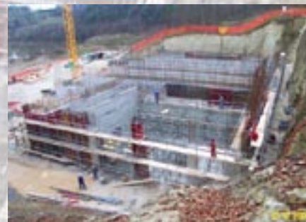
Stanje na objektu novembra
