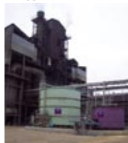
Čistilna naprava za čiščenje razklopnih plinov
