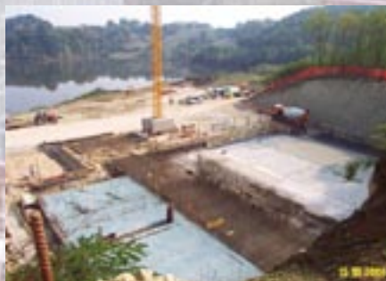
Stanje na objektu septembra oktobra
