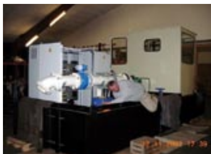
Črpalna in elektro omarica na plavajočem bagru
