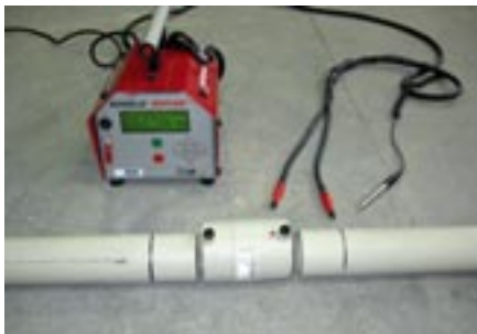
Cevi in spojke so očiščeni ter pripravljene na varjenje
