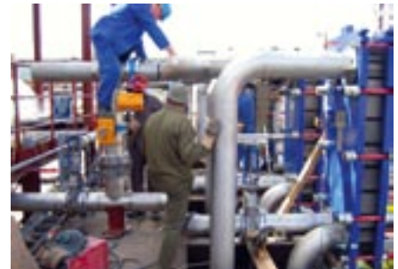
Montaža novih cevovodov za kislino
