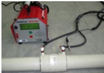
Varjenje cevi z elektroporovno spojko
