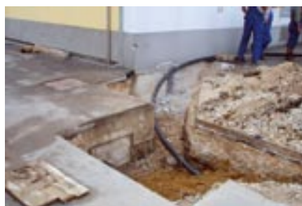
Nov cevovod za deka-vodo pri cinkovih zlitinah
