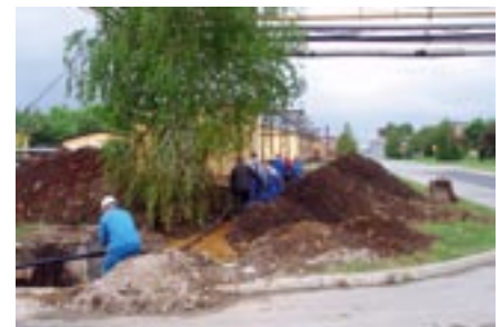
Polaganje elektro-kabla za napajanje obrata Žica
