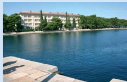
Opustele stavbe, za obnovo najbrž ni denarja
