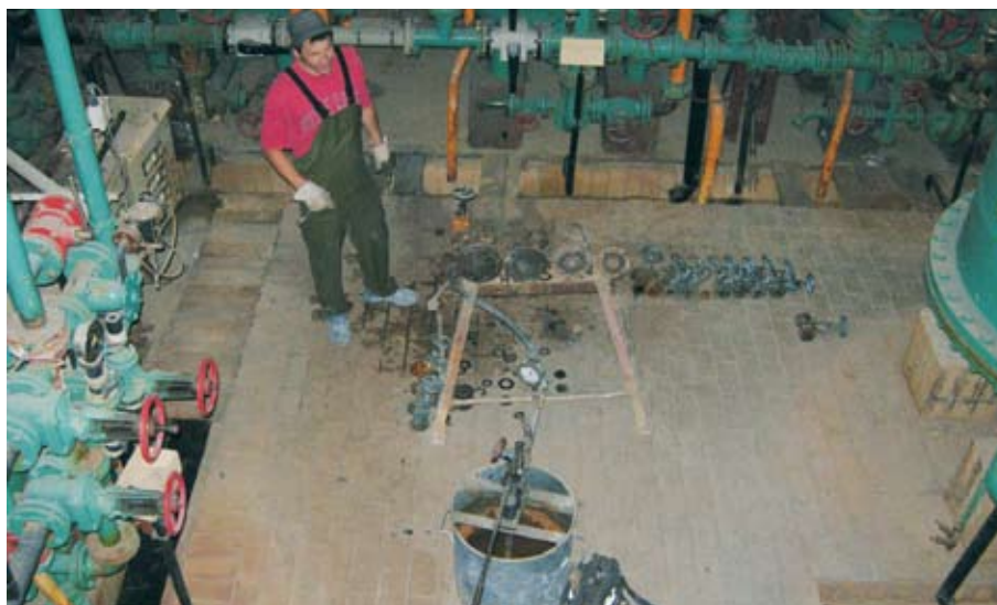
Remont in preizkus ventilov za parni kotel PK 400
