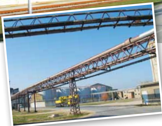
Stari energetski most s parovodom, ki je potekal ob nekdanji »fero« in »piritni« liniji žveplene kisline
