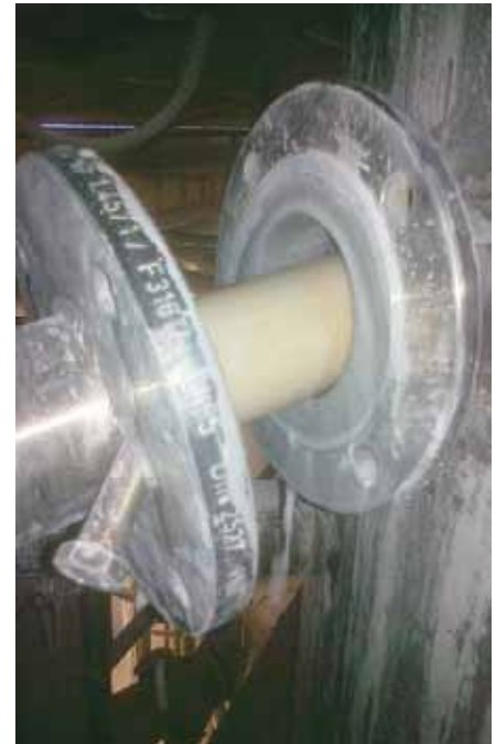
Montaža merilne sonde
