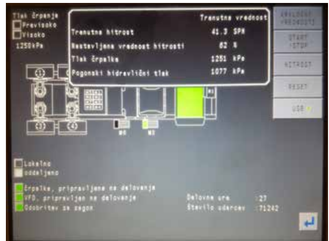
Kontrolni panel črpalke
