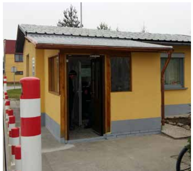
Novo zgrajen prizidek
