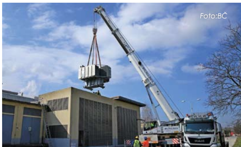
Vstavljanje novega transformatorja v trafo boks
