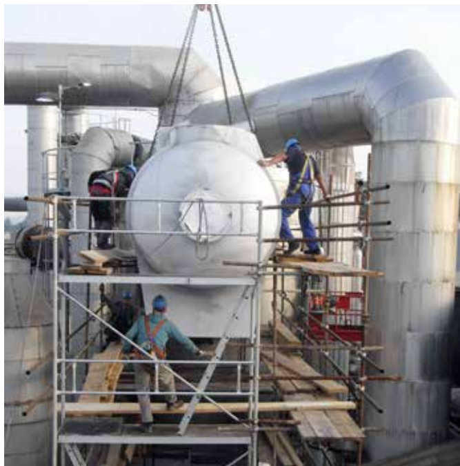
Spušcanje novega 03.07 DIMNOCEVNEGA KOTLA 2. (Peter Mravlak)
