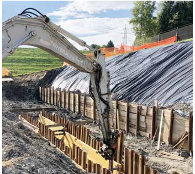
Z izgradnjo drenaže bomo preprečili dotok čiste podzemne vode v telo odlagališča.
