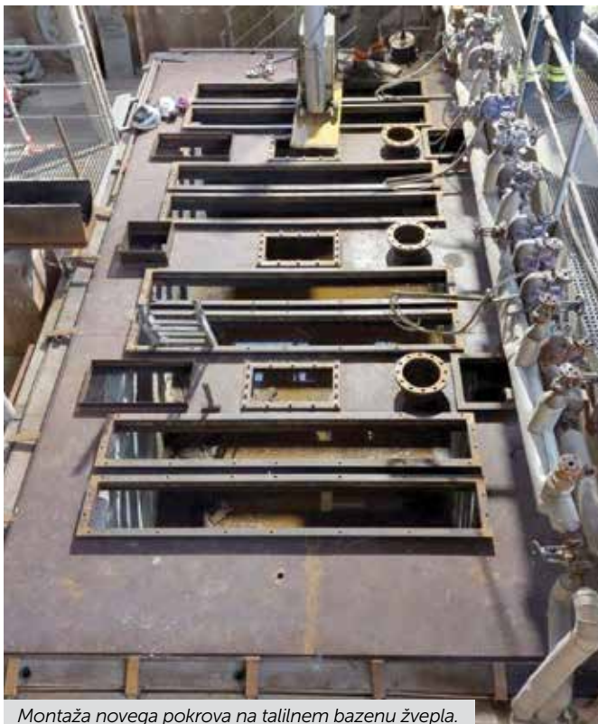
Montaža novega pokrova na talilnem bazenu žvepla.
