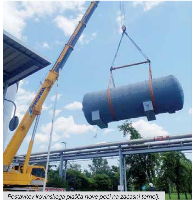
Postavitev kovinskega plašča nove peči na začasni temelj.
