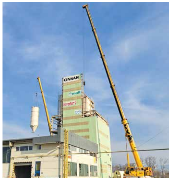
Demontaža stolpa za proizvodnjo gradbenih mas. (foto: Amadej Kujan)
